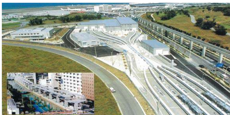
モノレール運営基地
