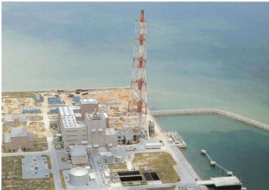
石川火力発電所
