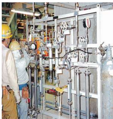
計装配管工事
