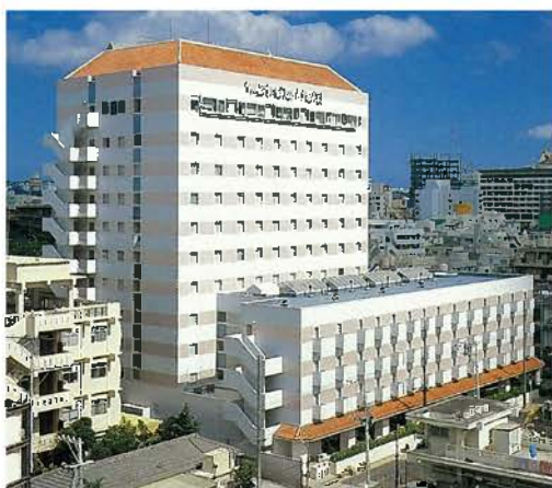
沖縄ワシントンホテル(昭和63年)
