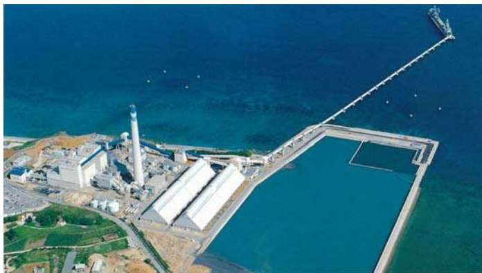
具志川火力発電所(平成7年)
