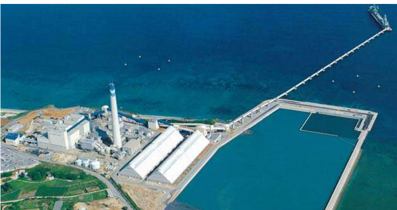
具志川火力発電所
