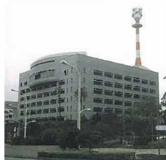
沖縄県警察棟(平成5年)
