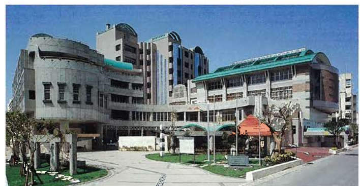
沖縄県自治研修所及び女性総合センター(平成8年)
